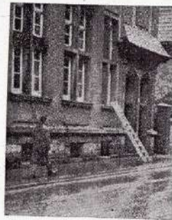
In die Sterkrader Stadtparkasse kletterten die Bauern, solange das Wasser noch durch die Straßen flutete, nur über eine Leiter durchs Fenster in die Diensträume.
