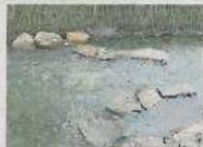
Wie ein umgekehrter Trichter steht diese Bühne zur Fließrichtung der Ohrn.
