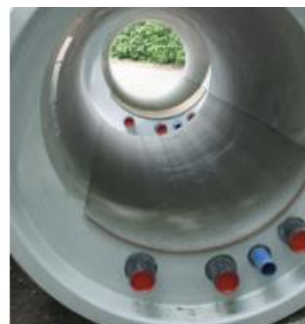
Kanalinterner Wärmetauscher Fa. Rabtherm
