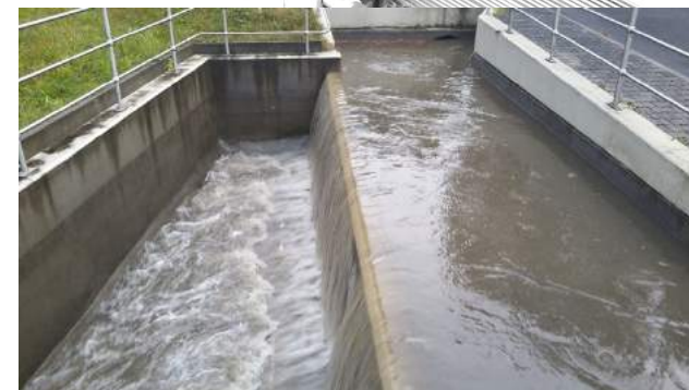
Notentlastungsbauwerk – B80 Kläranlage
