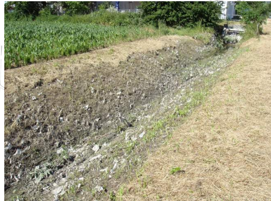
Stark mit Grobstoffen verunreinigter Entlastungsgraben
