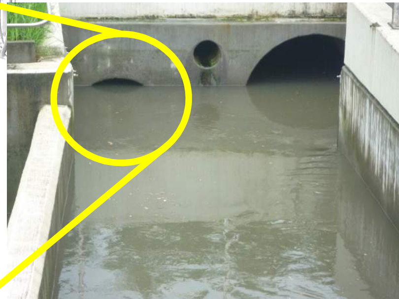
Rückstausituation bei Regennachlauf (Beckenentleerung)
