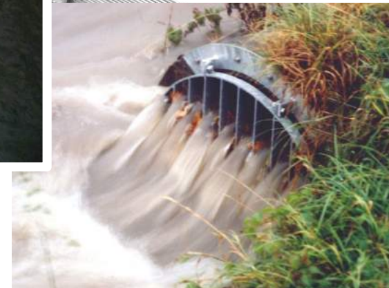
Teilverlegte Auslaufschutzgitter
