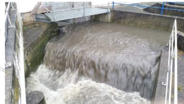
Trennbauwerk – B80 Kläranlage
