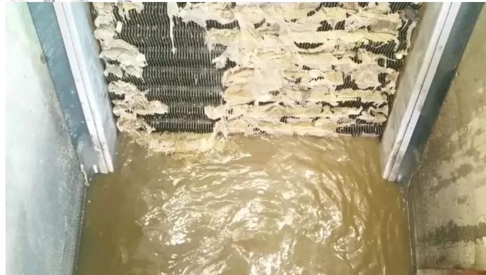
Rechengutablösung durch pulsierende Turbulenzen vor dem Rechen
