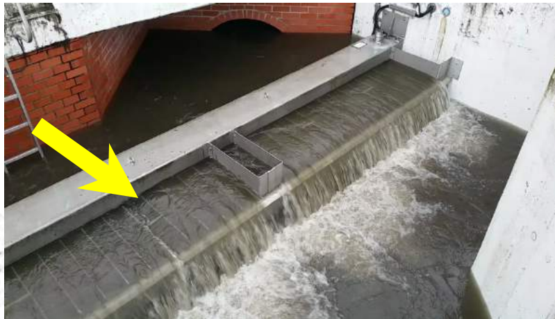
Räumeinrichtung (Bürstenwagen) im Zuflussquerschnitt
