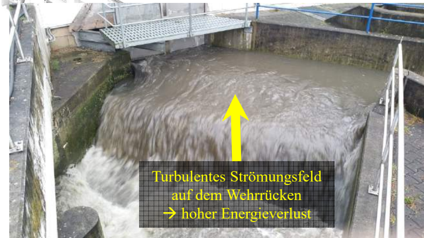
Überströmung einer breitkronigen Wehrschwelle
