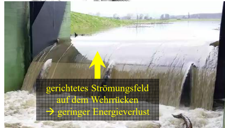
Überströmung einer strömungsoptimierten Wehrschwelle
