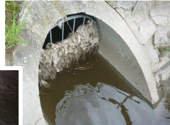
Teilverlegte Auslaufschutzgitter
