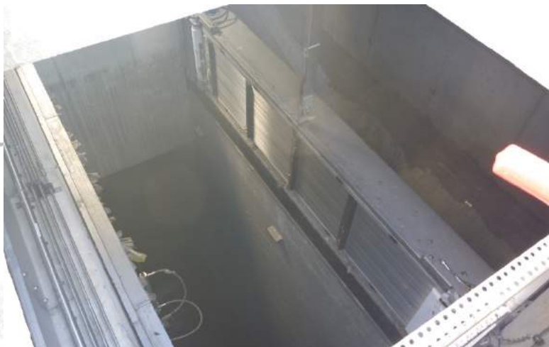
Standardnotentlastungsschwelle (breitkroniges Wehr)
