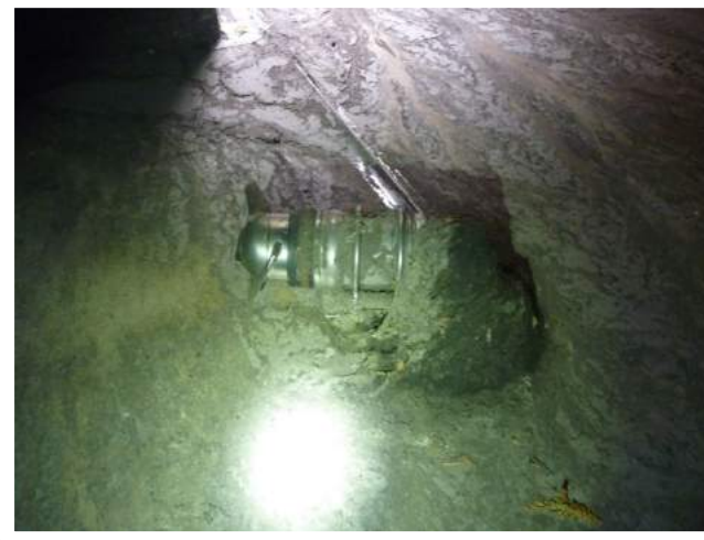
Verzopfungen an einem Rührwerk
