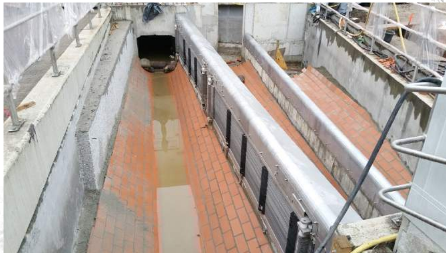
Trenn- und Beckenüberlaufbauwerk mit Rechenanlage (Bauphase)
