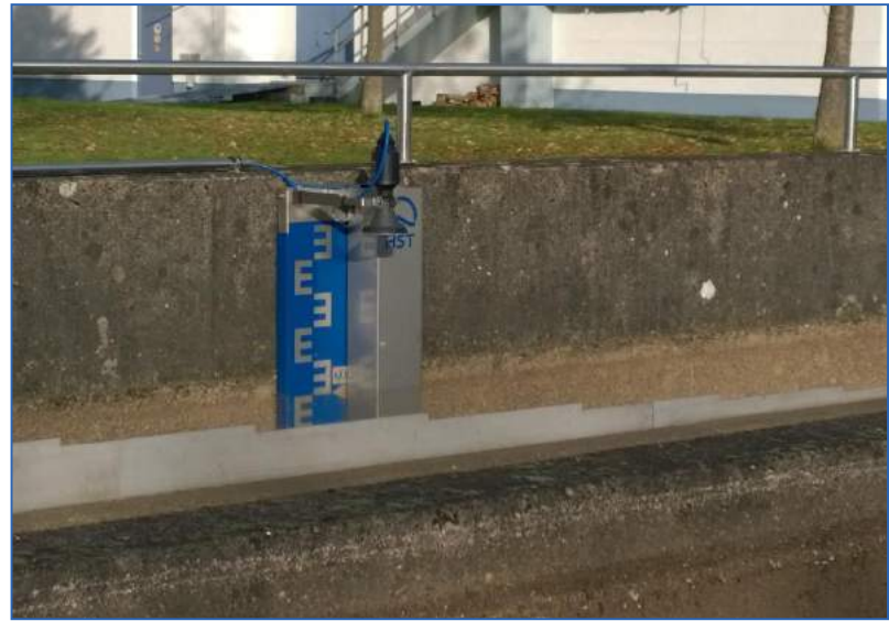
RÜB Lebach - Messstelle
