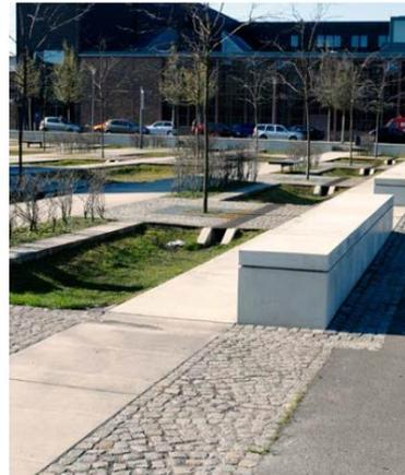
Abb. 10: Beispiel für in die Platzgestaltung integrierte Retentionsflächen
