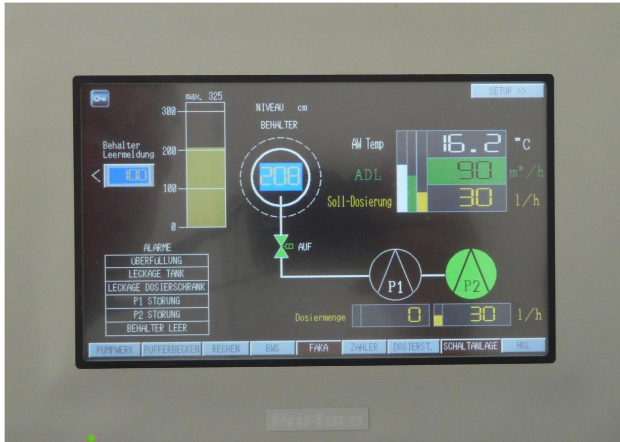
Steuerung integriert in PW-Steuerung, Visualisierung auf Paneel im PW
