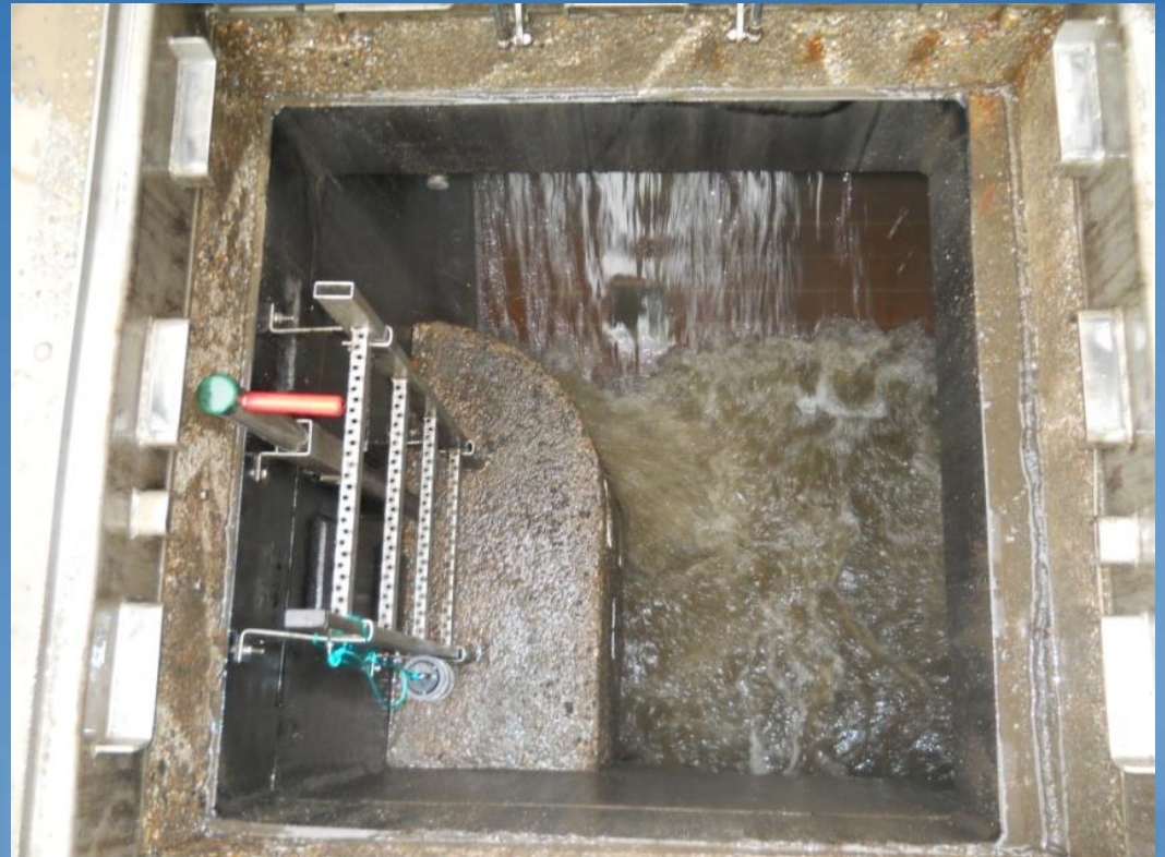
Druckleitungsendschacht
