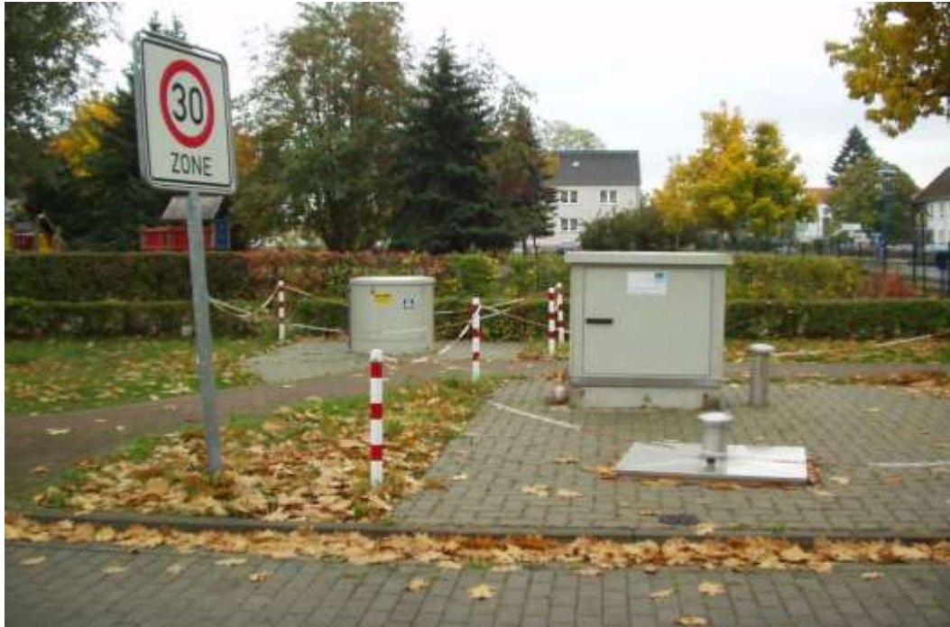
Zugabe von NUTRIOX (5 m 3 Tankanlage)
