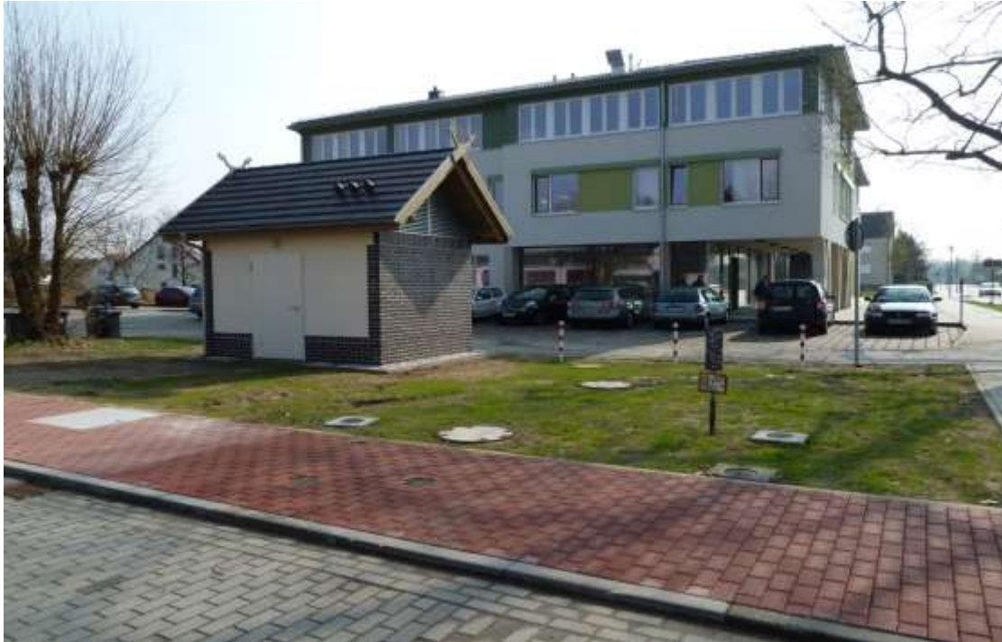
Zugabe von NUTRIOX (5 m 3 Tankanlage) und Behandlung der Abluft aus den Abwasserkanälen mittels PURAFIL
