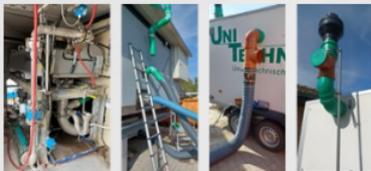
Photoreihe Anschluss der mobilen Abluftbehandlungsanlage an die Zentrifuge
