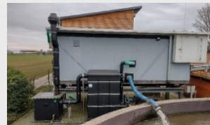
Neu errichtete stationäre Abluftbehandlungsanlage für die Schlammwässerung
