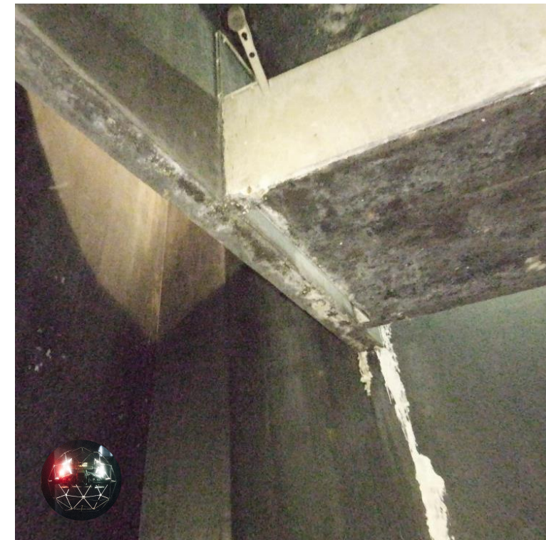
Weil am Rhein: fall structure
