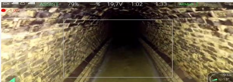
Live-Bild der Kanaldrohne bei der Befliegung
