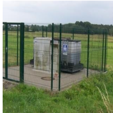
Chemikaliendosieranlage Nitrate
