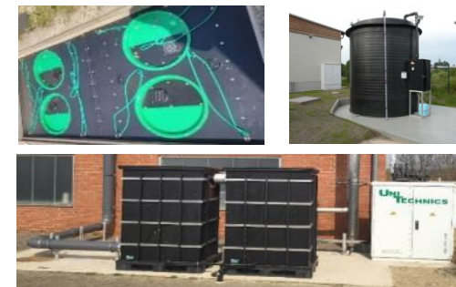
UNITECHNICS Anlagen- und Sonderbau
