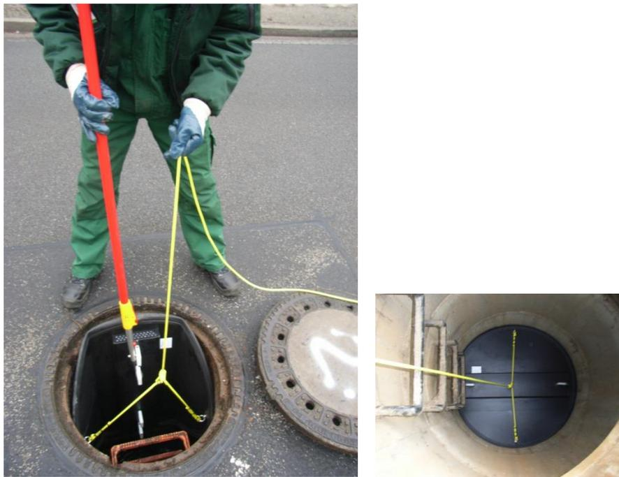
Für Pumpwerke wurde ein entsprechendes System, **das Amorphe Abdecksystem**, entwickelt. Mit dem gemeinsamen Einsatz beider Systeme kann ein flächiger bzw. linienförmiger Effekt erreicht werden, der im gesamten betroffenen Entwässerungsgebiet das Austreten von Geruchsstoffen verhindert und gleichzeitig vor Korrosion schützt. Der Erfolg ist in der Gasphase messbar.
