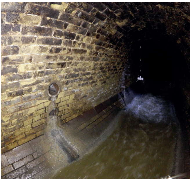
Bild 1: Drohnenaufnahme eines Hauptsammlers mit Einbindung
