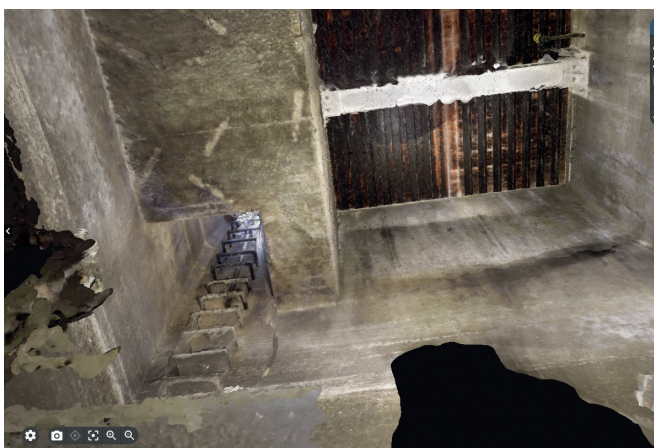
Bild 4: Photogrammetrische 3-D-Aufnahme des Einstiegschachts eines Regenüberlaufbauwerks
