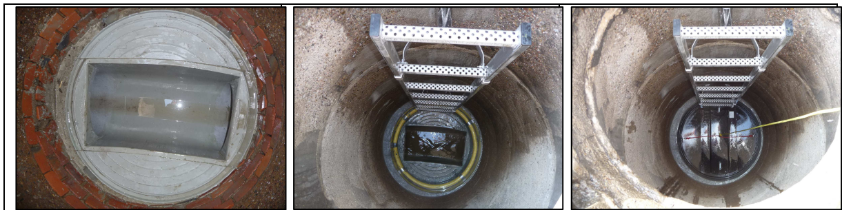
Abbildung 10: Schacht – Lübbecke r Straße (Durchmesser 1m), links:instandgesetztes Schachtunterteil, mitte:instandgesetzter Schacht mit Auflagerring für das Geruchsdämpfungssystem, rechts: instandgesetzter Schacht mit Geruchsdämpfungssystem
