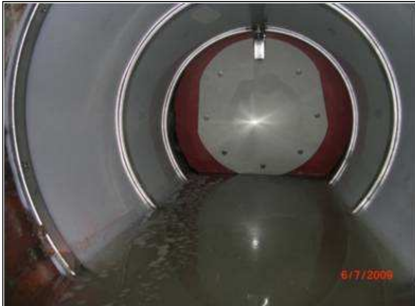
Abbildung 11: Geruchsverschlussklappe für Nebensammler
