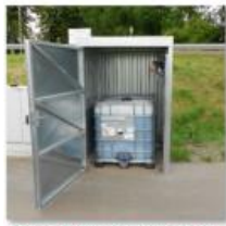
Chemikaliendosierstation Eisen
