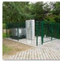
Chemikaliendosieranlage Nitrate
