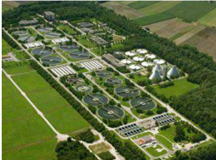
München, Gut Marienhof, 1 Mio. EW P-RTC Installation
