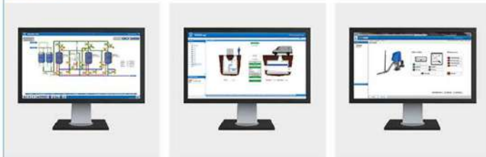
SCADA V10 Leittechnik, Client-Server-Lösungen
