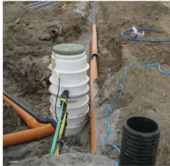
Bild 2: Vakuumschacht mit Freispiegelanschluss
