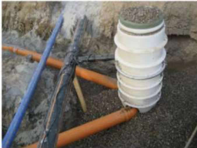
Bild 2: Vakuumschacht mit Freispiegelanschluss
