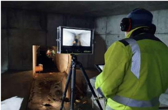
Live-Bild der Kanaldrohne bei der Befliegung
