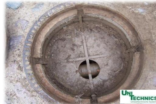
Die Lösung: Unitechnics Wasserverschluss-System FRK
