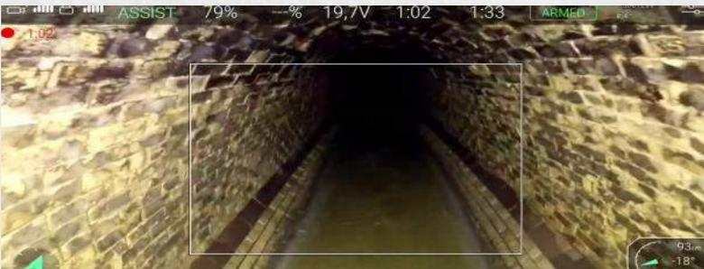
Live-Bild der Kanaldrohne bei der Befliegung
