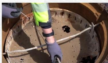
7. Jetzt das Seil durch das Seilverschluss **straffziehen** bis das Gewicht der Rattenkugel zu spüren ist (Rattenkugel muss auf der Berme stehen bleiben). Das Seilverschluss fixiert automatisch das Seil.
