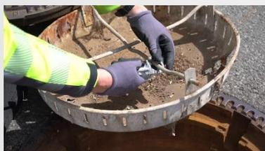
4. Seilverschluss am Schmutzfänger oder an der zusätzlich erhältlichen Einhängestrebe befestigen.
