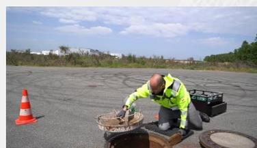
3. Schachtdeckel öffnen und Schmutzfänger entfernen.
