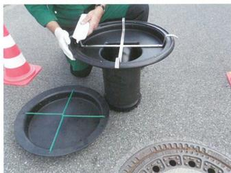
Abb. 2: Das Fremdwasserverschluss-System
