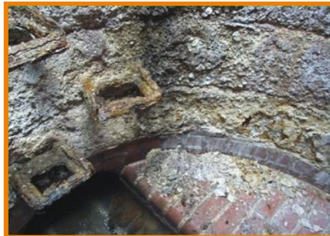
Beispielbild: biogene Korrosion in einem Schacht
