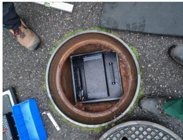
Zur Auflage des eckigen Geruchsdämpfungs-Systems wurden vier Aufschlagwinkel aus Edelstahl montiert.
