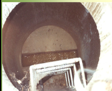
Schacht ohne Korrosion
