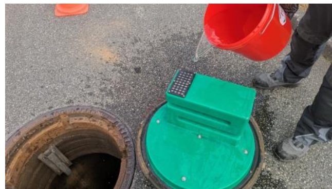
4. Die Unterseite des Systems reinigen und den Filterkorpus mit klarem Wasser spülen.
