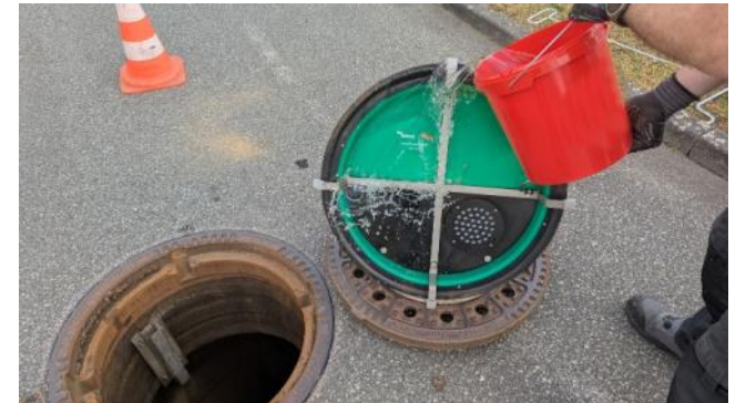
3. Geruchsdämpfungs-System mit klarem Wasser von Verschmutzungen befreien.
