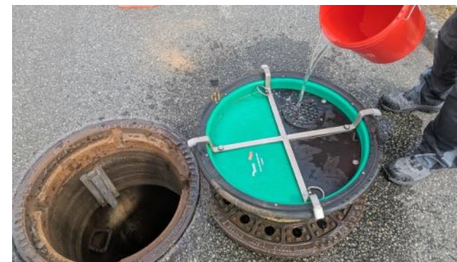
5. Filterkorpus von der Oberseite mit klarem Wasser durchspülen.
