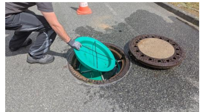
6. Gereinigtes System und Schmutzfang wieder in den Schacht einsetzen. Schachtabdeckung wieder verschließen – fertig!
