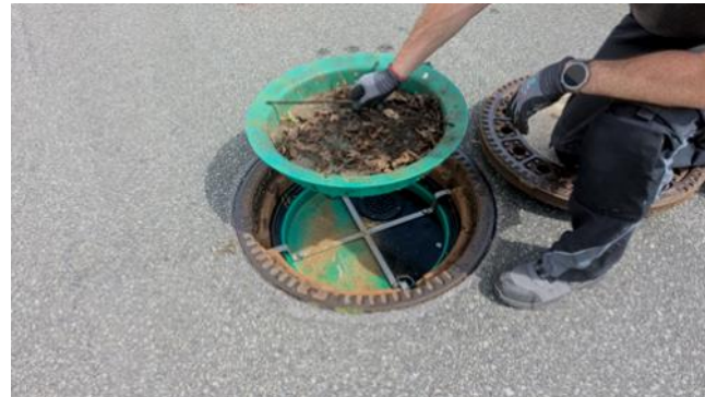
1. Schachtabdeckung öffnen, Schmutzfang entnehmen und leeren.
