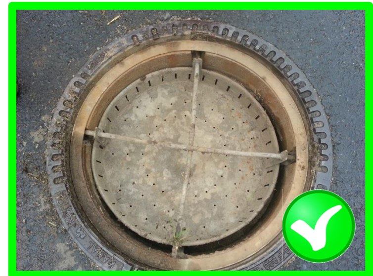
Schmutzfänger nach Reinigung
