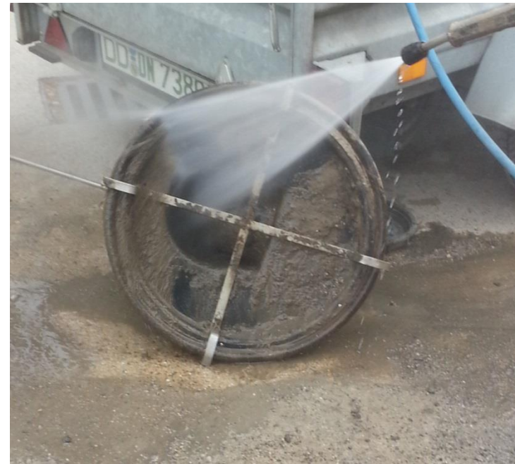
Wasserverschluss-System durchspülen
