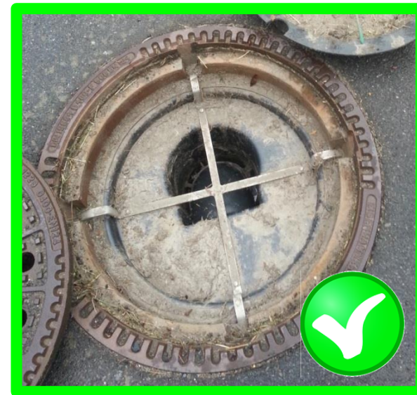
Platte unten – System muss nicht gereinigt werden
