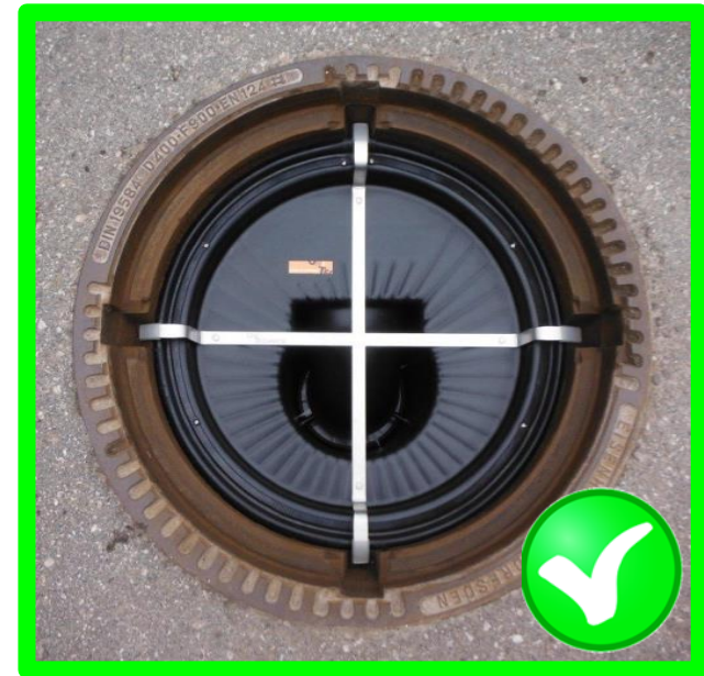
UNITECHNICS Fremdwasserverschluss-System nach der Reinigung
