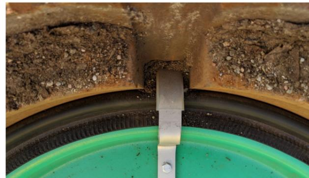
4. Auflage des Haltekreuzes in den Einhängenuten des Schachtdeckelrahmens und richtigen Sitz der Randdichtung überprüfen
