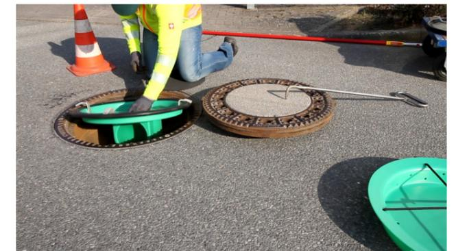
3. Fremdwasserverschluss-System mit leichter Kippbewegung und leichtem Druck von oben einsetzen
