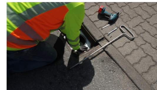
8. Havarieverschluss-System einsetzen
