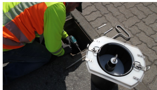
7. Fixierungsbohrungen (Durchmesser 6-8 mm) ca. 5 mm tief beidseitig einbringen
