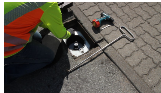
4. Fixierungsschrauben M6 aus dem HVS-K herausschrauben
