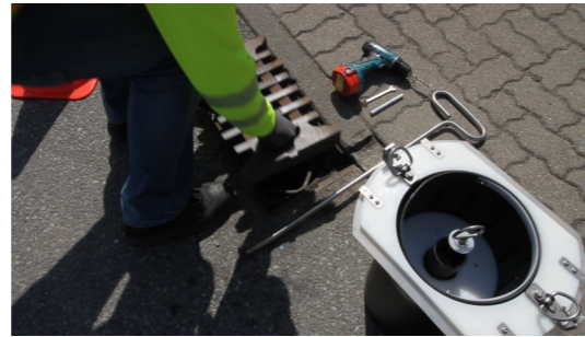
1. Gitterrost entnehmen
