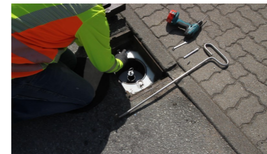
5. Position für Fixierungsbohrungen im Schachtdeckelrahmen mit einem Stift markieren
