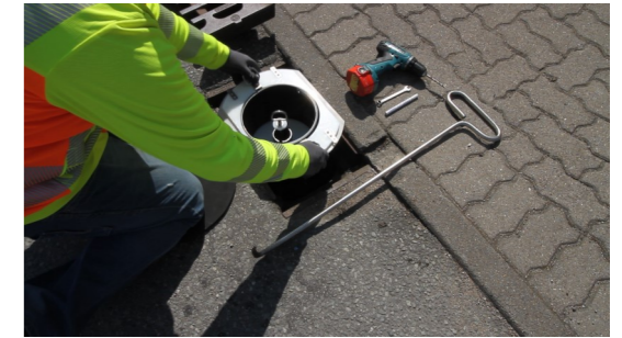
3. Havarieverschluss-System HVS-K einsetzen
