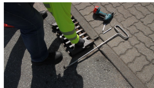
11. Gitterrost einlegen
