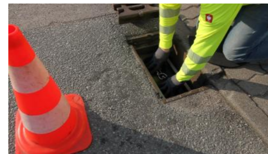
5. Havarieverschluss-System HVS-E in den Schachtdeckelrahmen herunterdrücken
