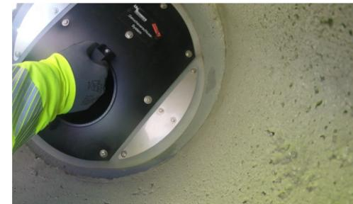
4. Geruchsverschluss-System GVS-450-150 am Griff nach unten drücken bis es aufliegt (die Dichtung muss nach oben geklappt an der Schachtwand anliegen)
