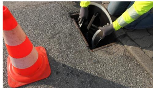
3. GVS-450-150 durch die Öffnung vom Straßenablauf einsetzen und um 90° drehen (die Öffnung des Rohrbogens muss in Richtung der Ablauföffnung vom Straßenablauf zeigen)
