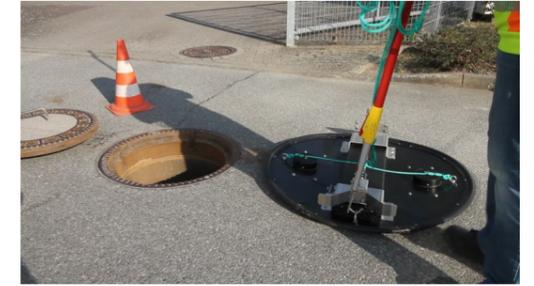
3. Bedienstange in die Öse einhaken und die Klappflügel mit Hilfe des Seils einklappen
