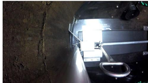
7. Seil gespannt halten und das System mit Hilfe der Bedienstange in die Waage-rechte nach unten drücken
