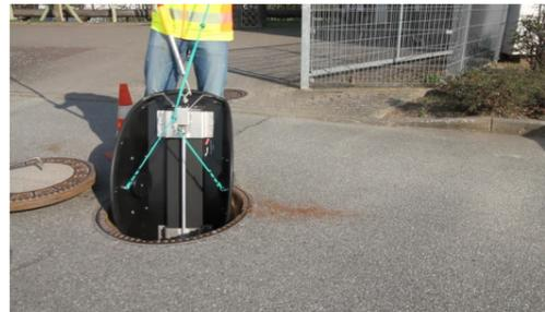
4. eingeklapptes System mit der Bedienstange in den Schacht herunter lassen
