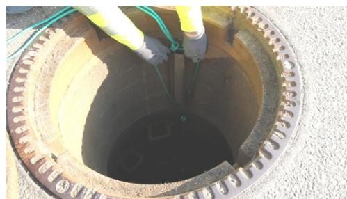
10. Montage des Systems abgeschlossen, das Seil am obersten Steigeisen oder am Schmutzfang befestigen
