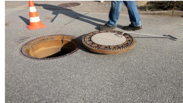
**2.** Schachtdeckel öffnen und Schmutzfang entnehmen (Schmutzfang wird nicht mehr benötigt)
