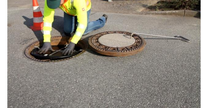
**3.** Fremdwasserverschluss-System mit leichter Kippbewegung und etwas Druck von oben einsetzen
