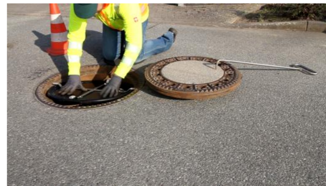
3. Fremdwasserverschluss-System mit leichter Kippbewegung und etwas Druck von oben einsetzen
