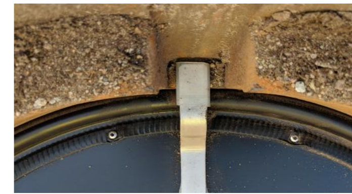
4. Auflage des Haltekreuzes in den Einhängenuten des Schachtdeckelrahmens und richtigen Sitz der Randdichtung überprüfen
