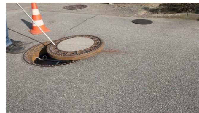
5. Schachtdeckel wieder verschließen, fertig!
