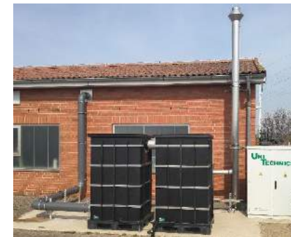
UNITECHNICS Anlagen- und Sonderbau
